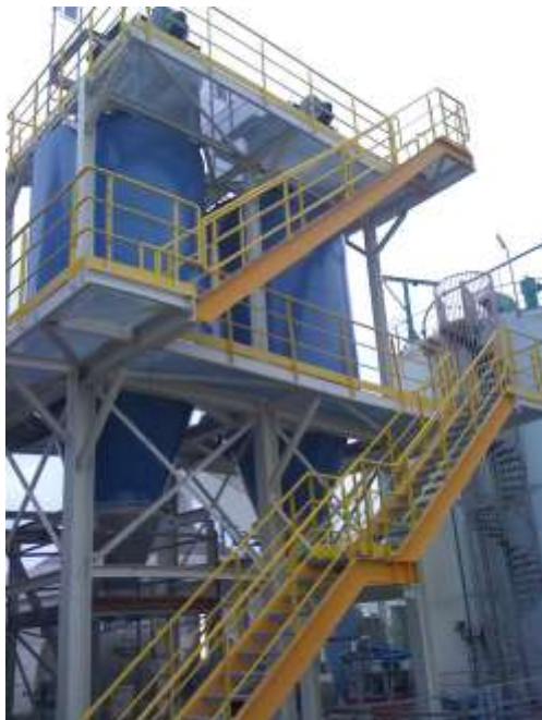
Structure métallique Lafarge Ciments La Malle
